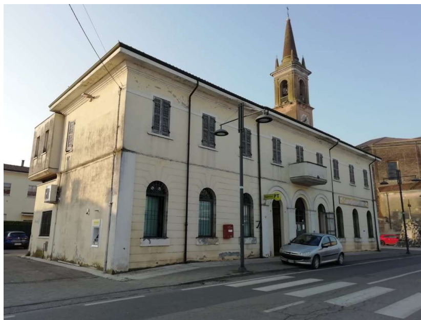
Fig. 3 – Malavicina, Via Piave 42: edificio della sala polivalente / ufficio postale, sede dell'androne di installazione.
